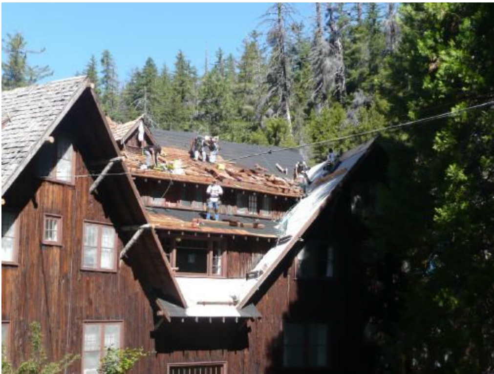
Bauarbeiten am Hotelkomplex vor den Caves
