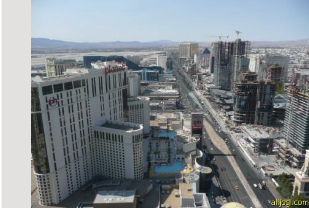
Und nun die Großbaustelle, der neue City Center.
